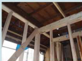
構造補強の様子
