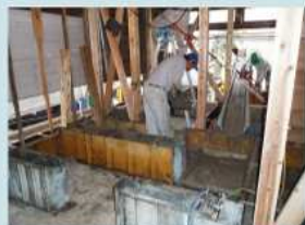
基礎工事の様子
