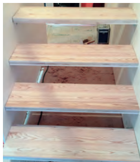
▲階段は国産材の集成材・Jパネルで造作しました。
