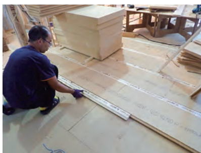
▼床には木製の断熱材・ECO断フロアを採用。直接床の上に敷けるので、床下から害虫が入ることがなくなります。
