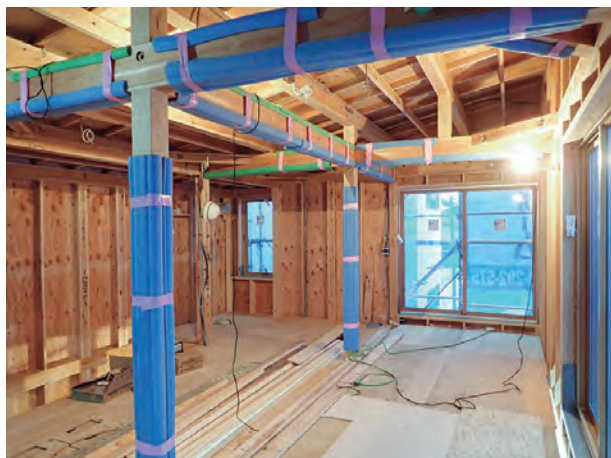
▼床には木製の断熱材・ECO断フロアを採用。直接床の上に敷けるので、床下から害虫が入ることがなくなります。
