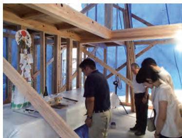
◀▲屋根の下地までできました。台風対策でシートに覆われていますが、上棟式も無事に終わりました。
