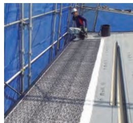
▼▶屋根には防水シートと通気シートを張り、ガルバリウム鋼板で仕上げました。
