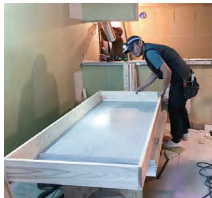
▲階段は国産材の集成材・Jパネルで造作しました。
