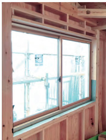
◀壁に構造用合板を張り、樹脂窓を取り付けました。Low-E ガラスなので断熱性も高くなっています。
