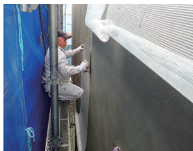
▲▶外壁は下塗り後、ジョリパット仕上げです。たくさんの職人さんで一気に仕上げます。
