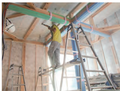
▲壁と天井に、リフォームでもお馴染みの断熱材・セルローズファイバーを吹き込みました。
