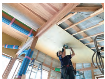
▲▶天井はボードを張って杉板張りに。吹抜け部分にはシーリングファンを取り付けました。
