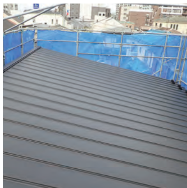
▼▶屋根には防水シートと通気シートを張り、ガルバリウム鋼板で仕上げました。
