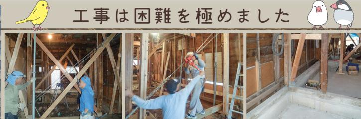
傾いた建物を荷締め機で引っ張りながら、パイプで支えて補強することを何度も繰り返して傾きを解消。ジャッキアップして土台と基礎を造りなおし、筋交いや金物で耐震補強しました。断熱工事、外部工事を経て、趣を大切に内部工事を行い、ようやく建物が再生されました。
